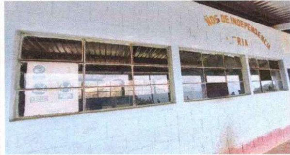
FOTO 2: INSTALCION DE BALCONES FRENTE AL ESTABLECIMIENTO
