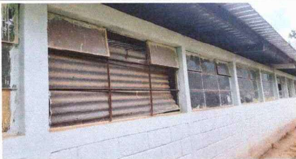
FOTO 3: REPARACION DE VIDRIOS DEL ESTABLECIMIENTO
