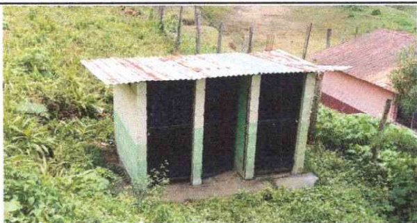
Foto 5: REPARACION DE BAÑOS
